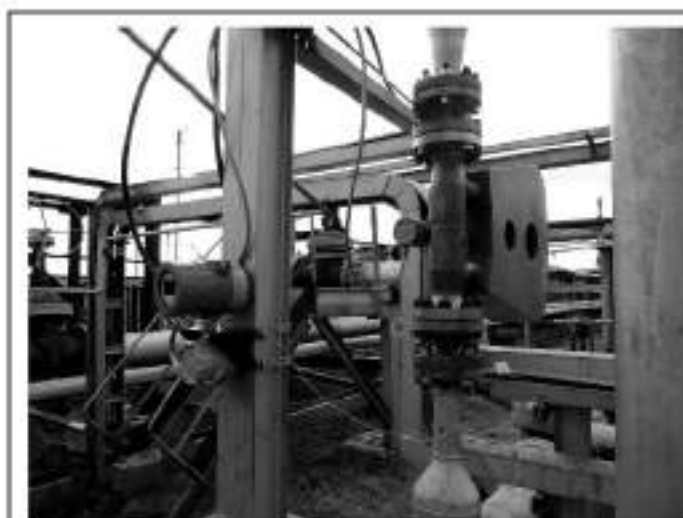
Рис. 1. Проект импортозамещения в нефтегазодобыче — обеспечение полной совместимости и качества работы кориолисового массового расходомера «ЭлМетро-Флоуик» в составе измерительной установки
