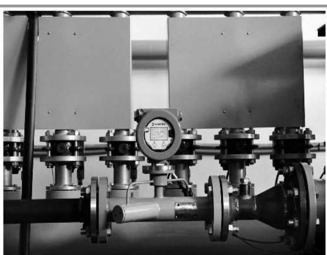
Рис. 2. Ультразвуковой газовый расходомер «ЭлМетро-СТУ» на базе DSP-технологий для учета газа на предприятии в Западной Сибири
