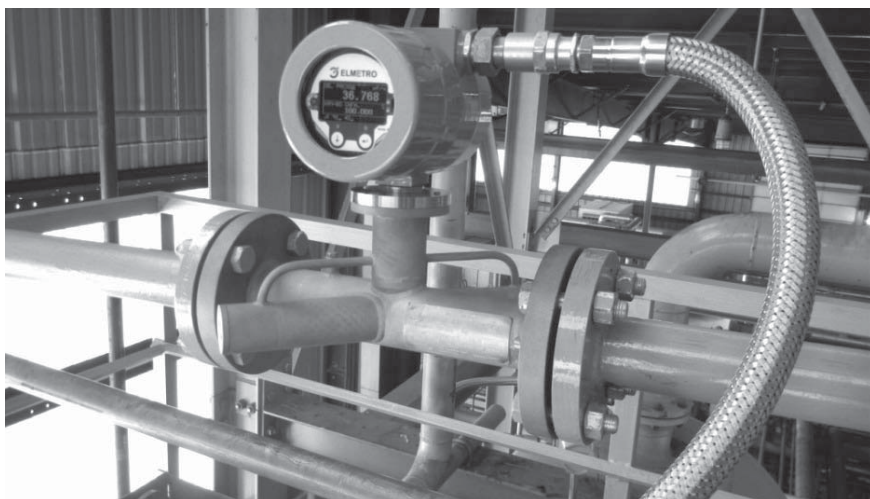
Рис. 2. Измерение попутного нефтяного газа или других отходящих газов — специализация ультразвукового расходомера «ЭлМетро-СГУ»
