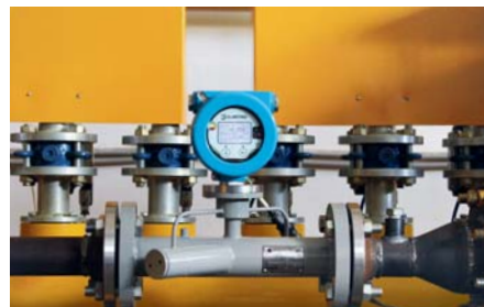
Ультразвуковой газовый расходомер «ЭлМетро-СГУ» на базе DSP-технологий для учета газа на предприятии в Западной Сибири
