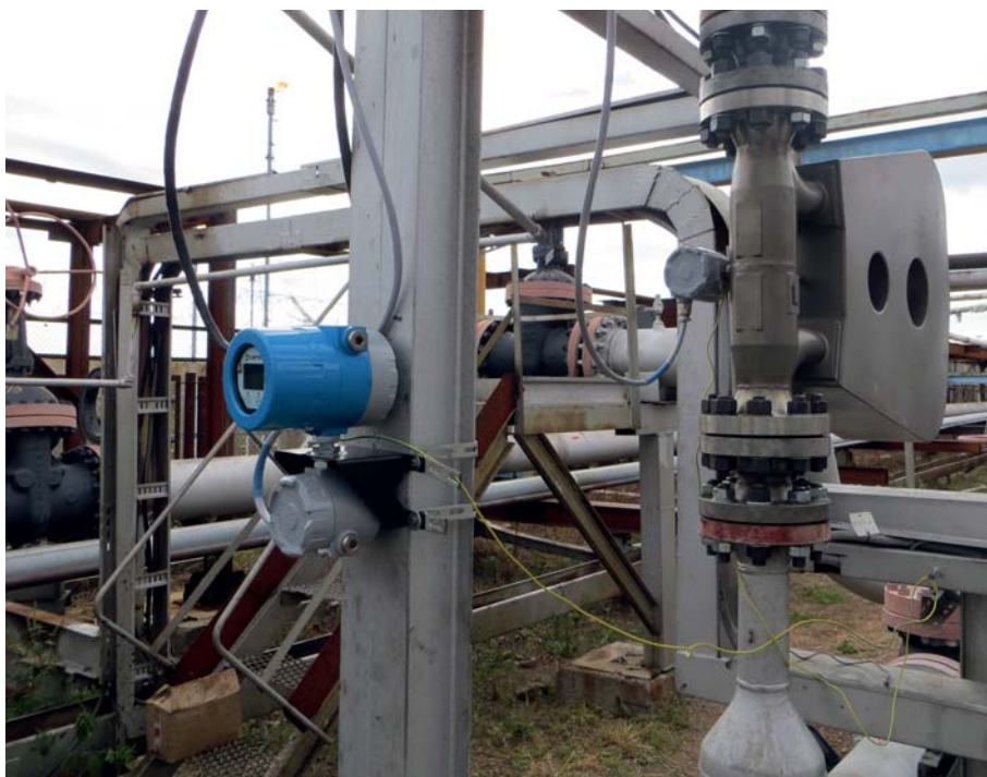
Проект импортозамещения в нефтегазодобыче – обеспечение полной совместимости и качества работы кориолисового массового расходомера «ЭлМетро-Фломак» в составе измерительной установки
